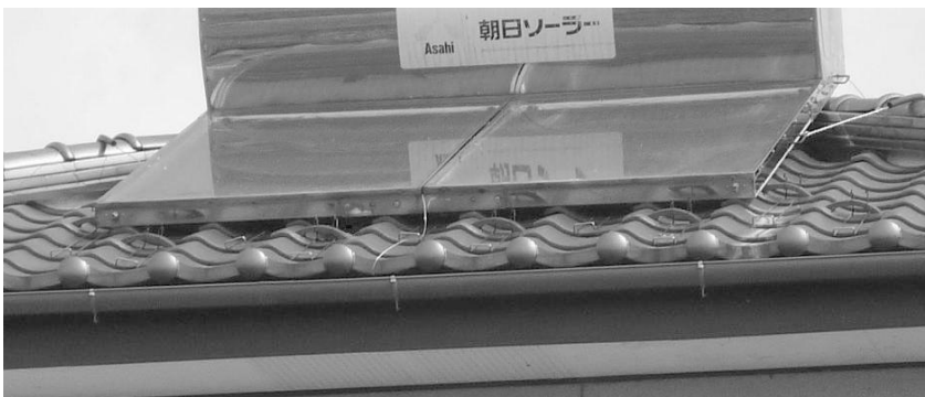
三州瓦屋根の施工事例
